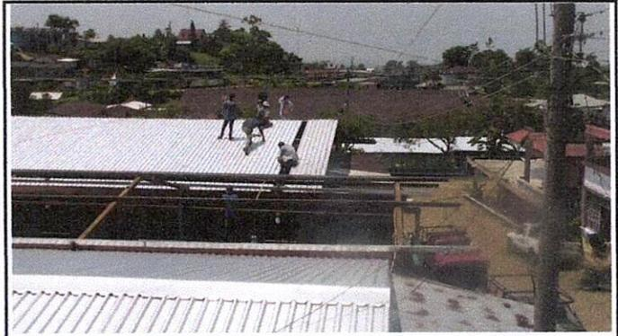
Foto 4: Colocación de laminas nuevas sobre edificio escolar.
