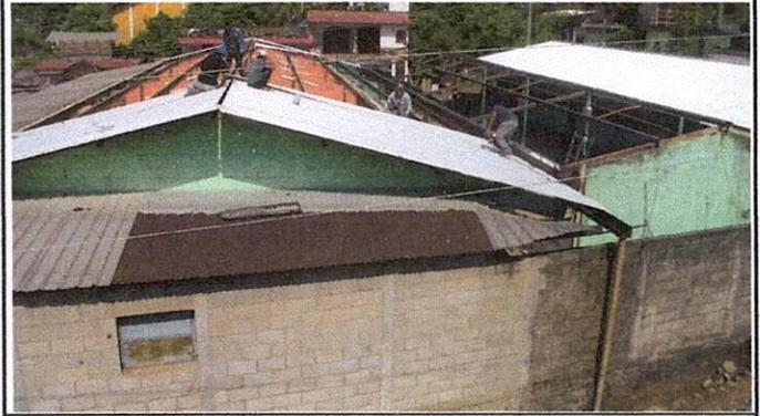
Foto 2: Empieza colocación de laminas nuevas sobre edificio escolar.
