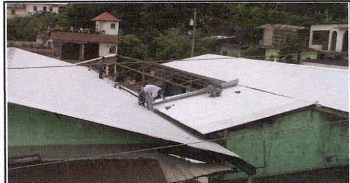
Foto 6: Colocación de laminas nuevas sobre area de recreación.
