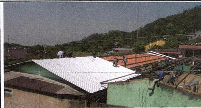
Foto 3: Colocación de laminas nuevas sobre edificio escolar.
