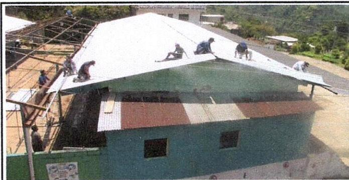
Foto 5: Colocación de laminas nuevas sobre edificio escolar.
